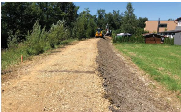
Es wird derzeit eine luftseitige **Erosionsmatte** angebracht, um den Damm vor sämtlichen Umwelteinflüssen zu schützen. Nach Abschluss dieser Arbeiten wird dieser wieder begehbar gemacht. Da sich der Weg nicht zur Gänze im öffentlichen Gut befindet, wird es jedoch wieder eine Durchgangssperre (Standorte wie bisher) geben. Die **Sanierung dieser Dammstrecke** war überaus wichtig, da nach Kanalarbeiten die Standfestigkeit gelitten hatte.
